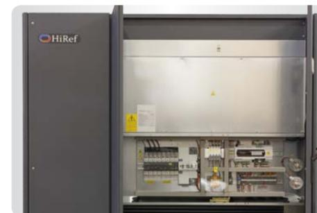
Die Einheit wurde mit großer Sorgfalt entwickelt, um auch auf der in Betrieb stehenden Einheit den Zugriff zu den Komponenten von vorne zu ermöglichen. Diese Eigenschaft erweist sich für die Normalwartungsarbeiten als vorteilhaft und sichert die Einhaltung der Sicherheitserfordernisse.
